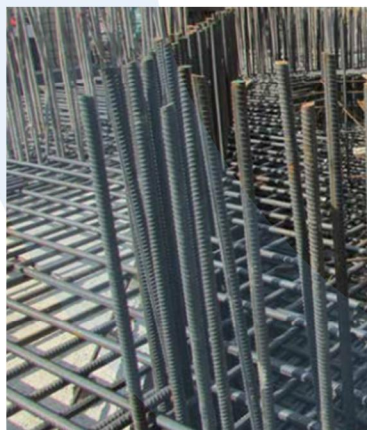
圖中顯示建築地盤突出的鋼筋，未有適當的防護措施，對附近工友構成危險。
