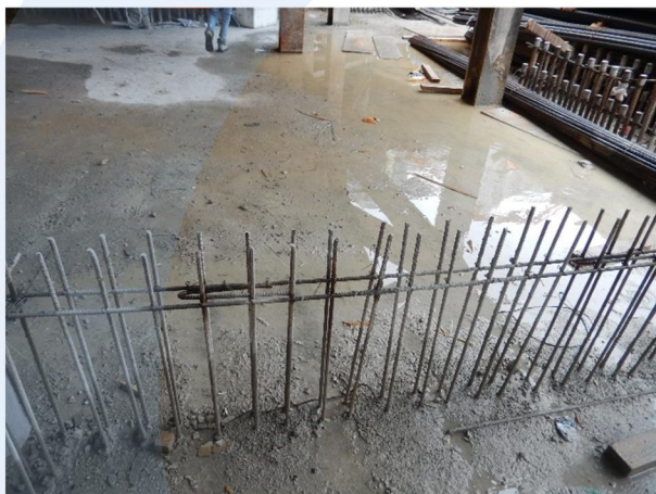
圖中顯示建築地盤突出的鋼筋，未有適當的防護措施，對附近工友構成危險。
